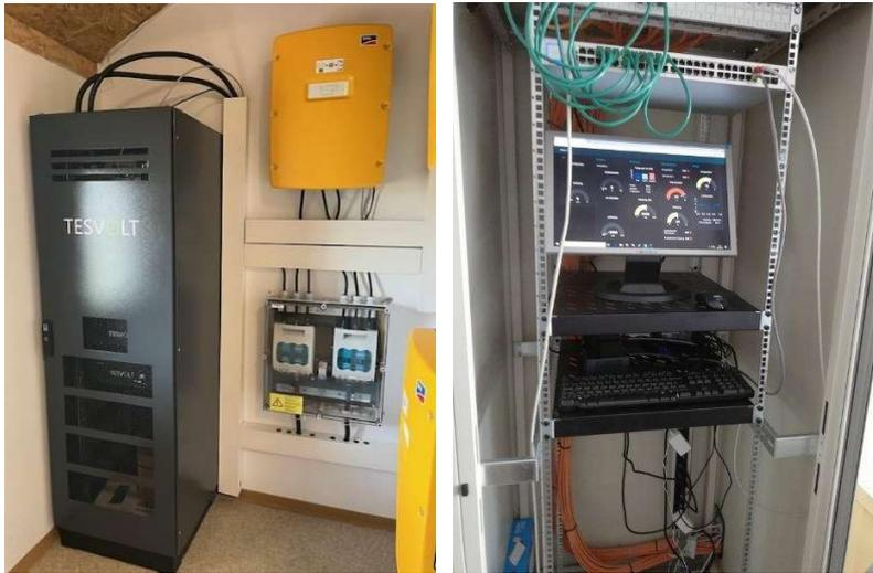
*Abbildung 5: Batterieschrank der Firma TESVOLT(links), eingebaut in den Wohngebäuden und Steuerschrank in Haus 7 (rechts) Foto: D. Rücker*
