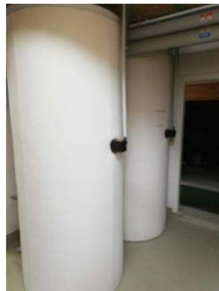
*Abbildung 4: Wärmepumpenanlage und Warmwasserspeicher Foto: D, Rücker*
